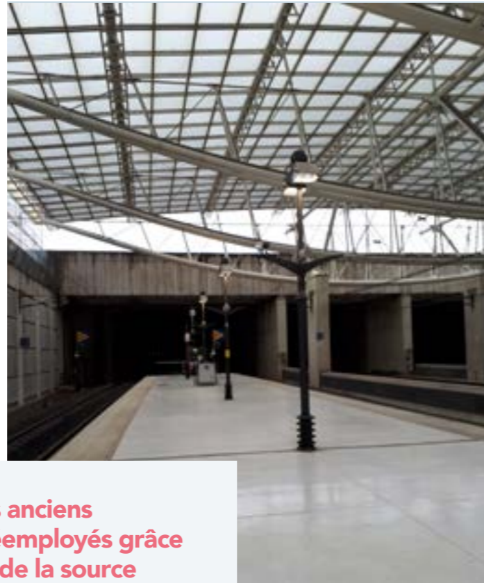
Réemploi de luminaires (MOA : SNCF G&C, MOE : AREP)
